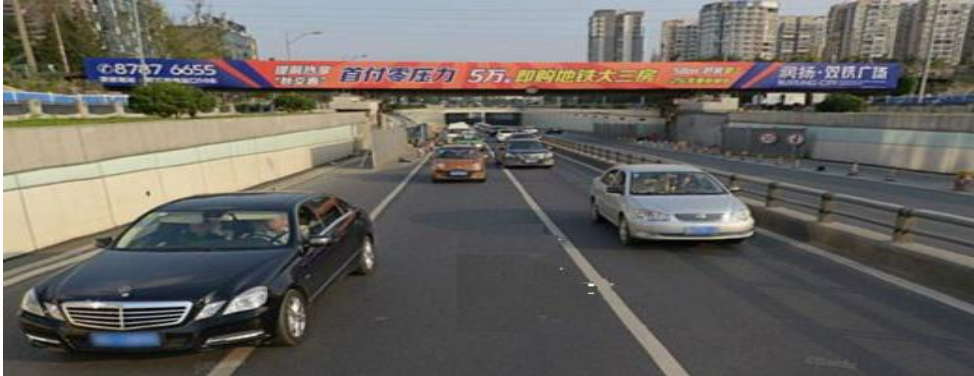
图1-24 现状金科南路位置下穿隧道现状
